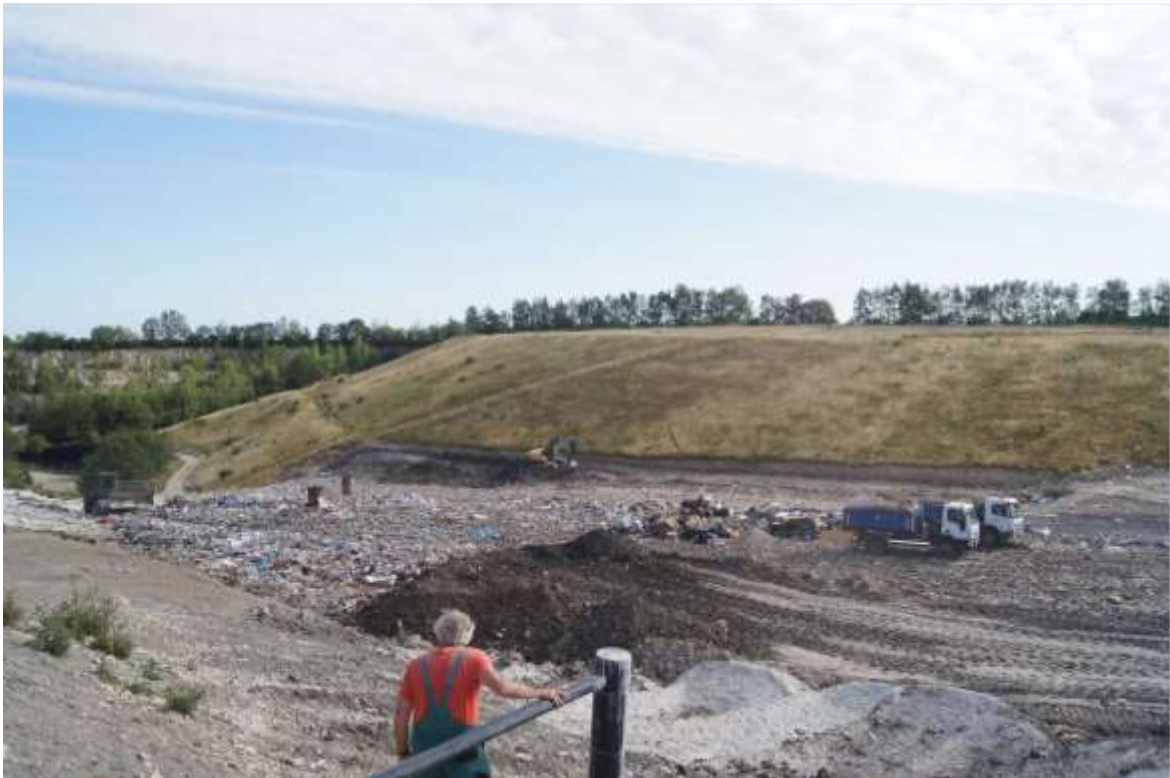
Obr. 8: Skládka komunálního a inertního odpadu v Lánech při odkryvu dříve ukládaných odpadů
