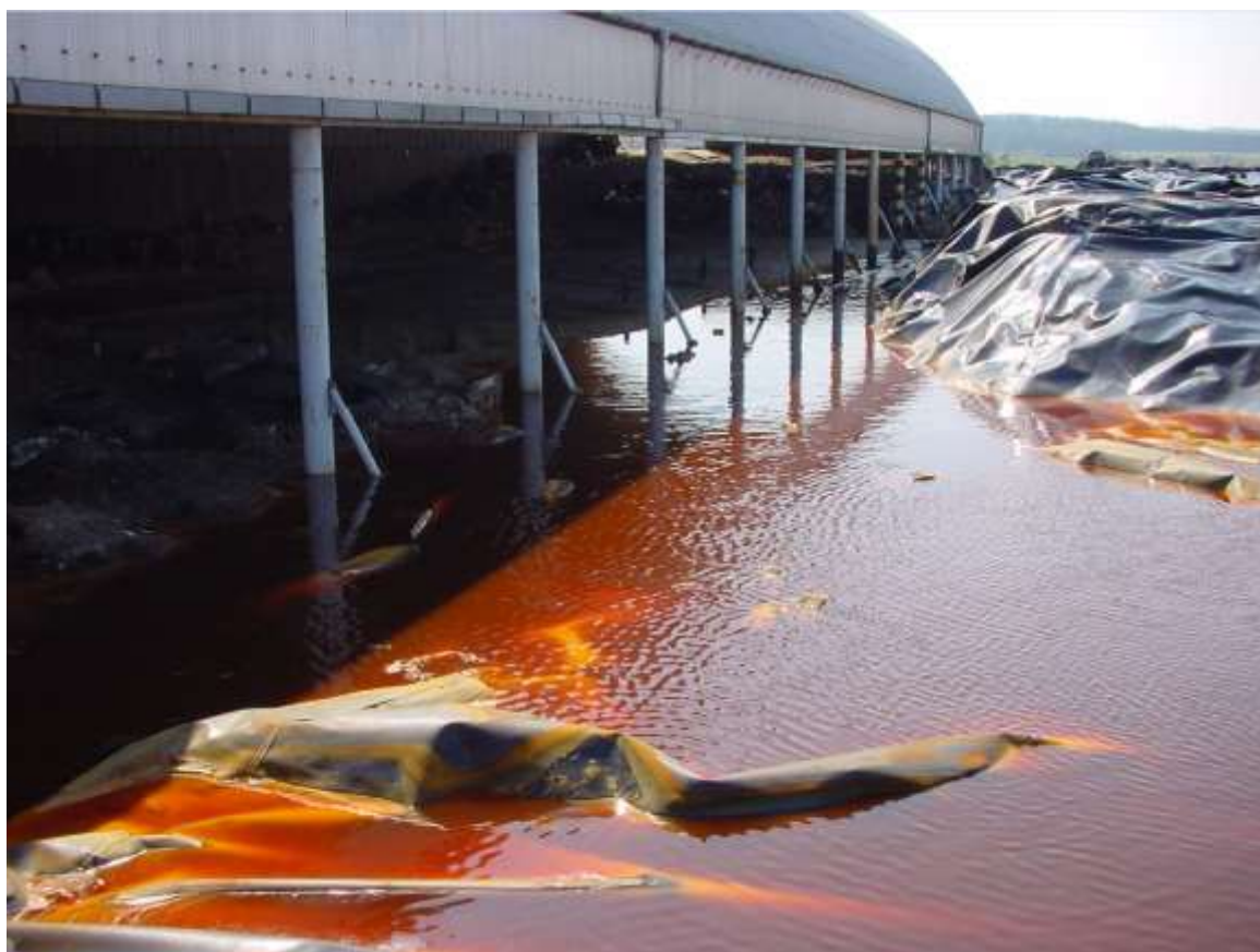
Obr. 7: Skládka nebezpečných odpadů v Pozd'átkách u Třebíče během havarijního stavu
