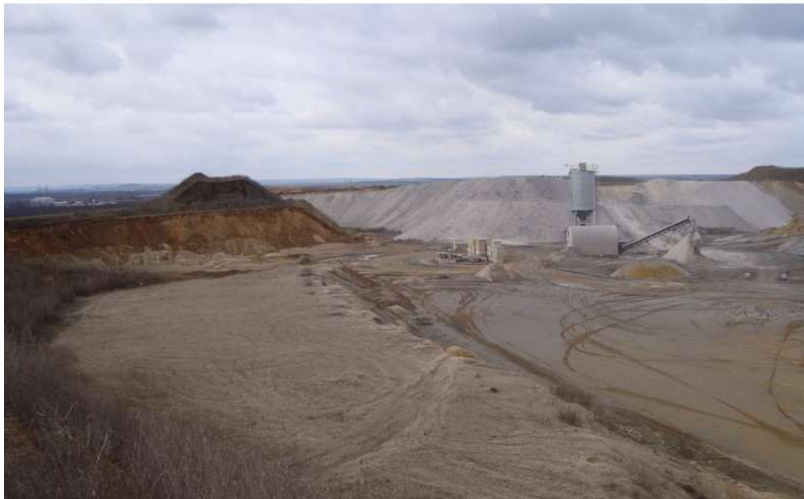
Obr. 3: Vytěžená část pískovny zavážená úletovým popílkem z fluidního spalování hnědého uhlí
