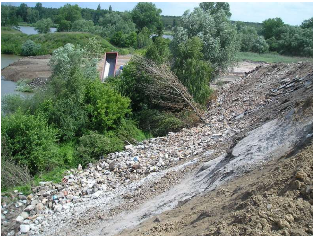
Obr. 5: Navážení výkopových zemin a stavebních odpadů na nechráněný povrch terénu
