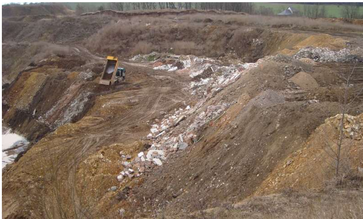
Obr. 4: Vytěžená část pískovny zavážená výkopovými zeminami a stavebním odpadem
