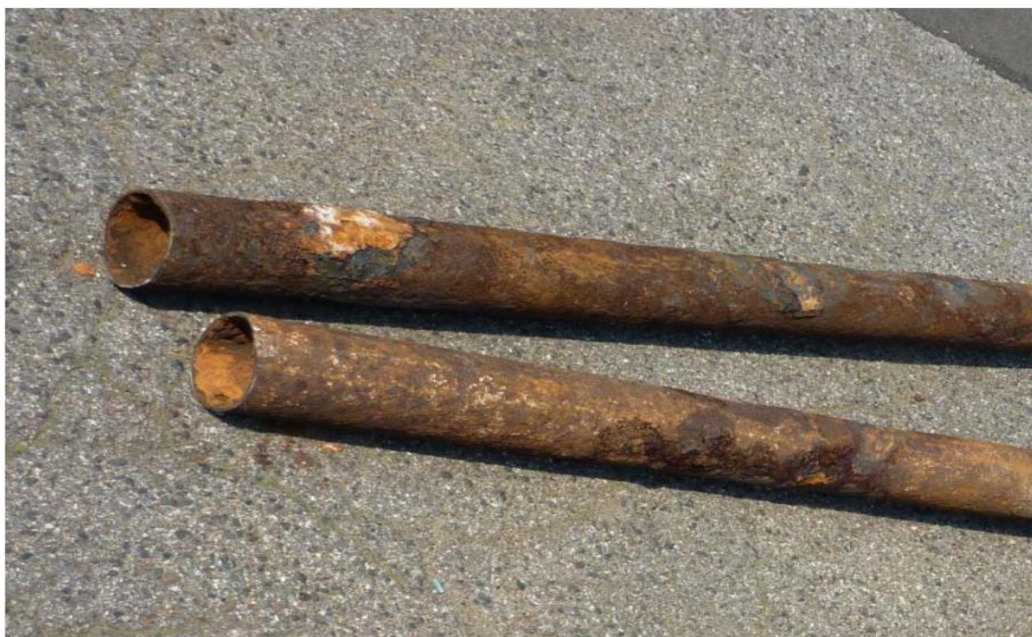
Obr. 1: Odebraný vzorek potrubí vykazuje velké napadení korozí
