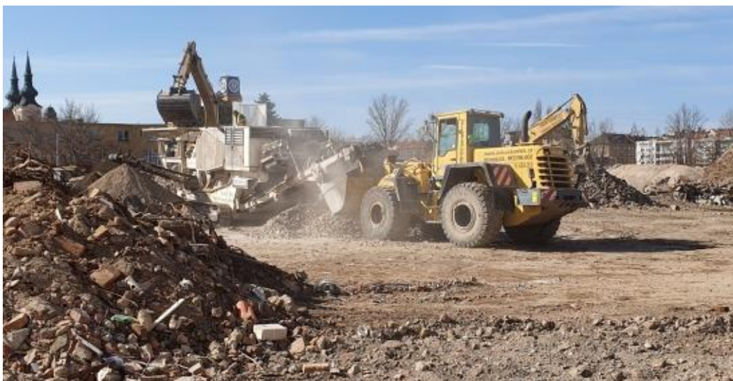
Obr. 3 Recyklace SDO v bývalém průmyslovém areálu (Brno březen 2022)
