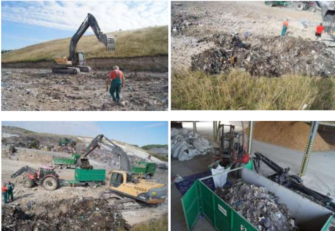
Obr. 13: Odtěžování komunálního odpadu uloženého ve skládce po dobu 20 let
