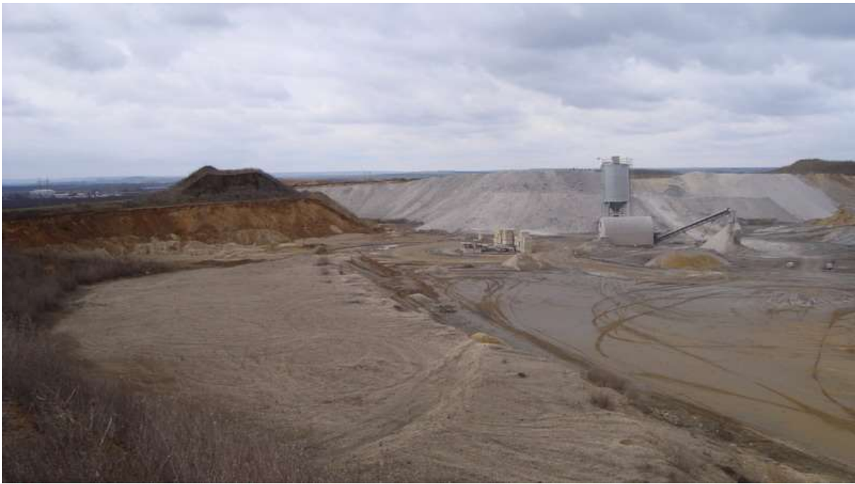
Obr. 4: Ukládání popílku z fluidního spalování hnědého uhlí do prostoru vytěžené pískovny.
