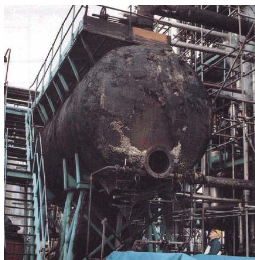
Obrázek 1- Destilační zařízení po havárii (HSE, 1994)
