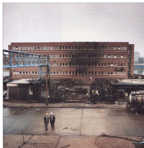
Obrázek 2 – Zasažená kancelářská budova (HSE, 1994)
